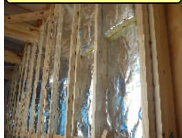
断熱材施工
