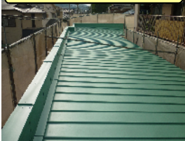
屋根ガルバ施工完了
