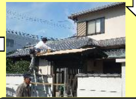
下地野地板新設
