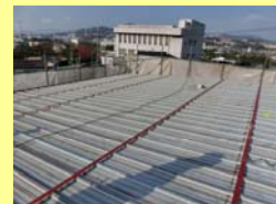
フラットバー取付
