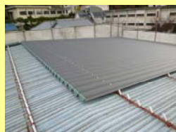
折半屋根取付
