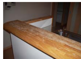
①表面が使用年月により劣化
